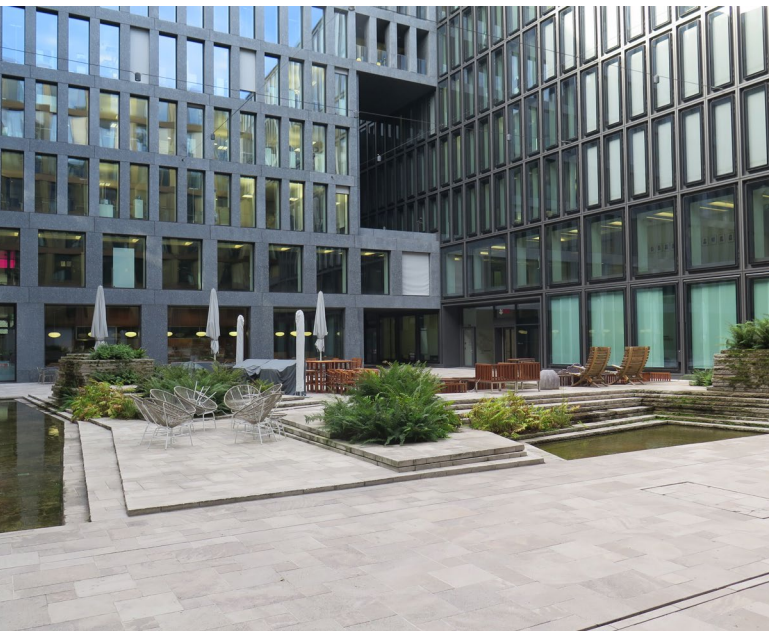
Dieser Innenhof entlang der Europaallee in Zürich ist ein abschreckendes Beispiel für störende Halligkeit. Da helfen auch ein paar Pflanzen nicht mehr.
