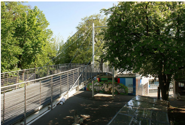
Photo 2 : L'installation sonore sert de passerelle entre l'école professionnelle industrielle et commerciale et le nouveau bâtiment « Campus ».
