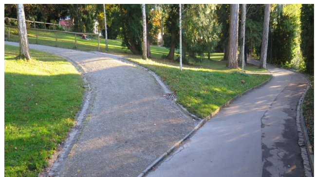
Oft genügt es in einer Parkanlage nur die wichtigsten Verbindungen zu asphaltieren. Bild: Thomas Gastberger
